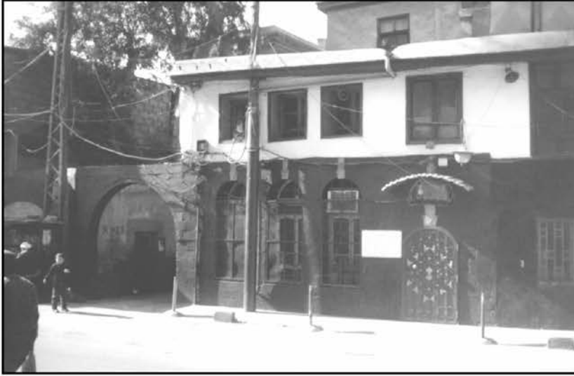
زقاق القرشي في حي الميدان جنوب مدينة دمشق ويظهر المدخل
