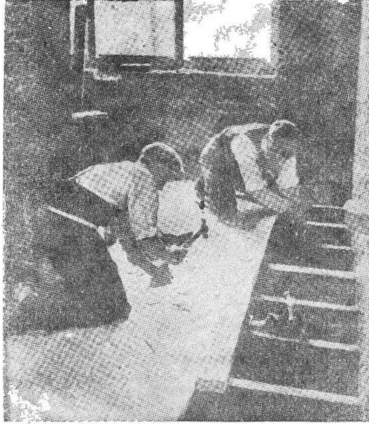
شكل (٦٧) انجارون يشبتون ألواح الارضية
