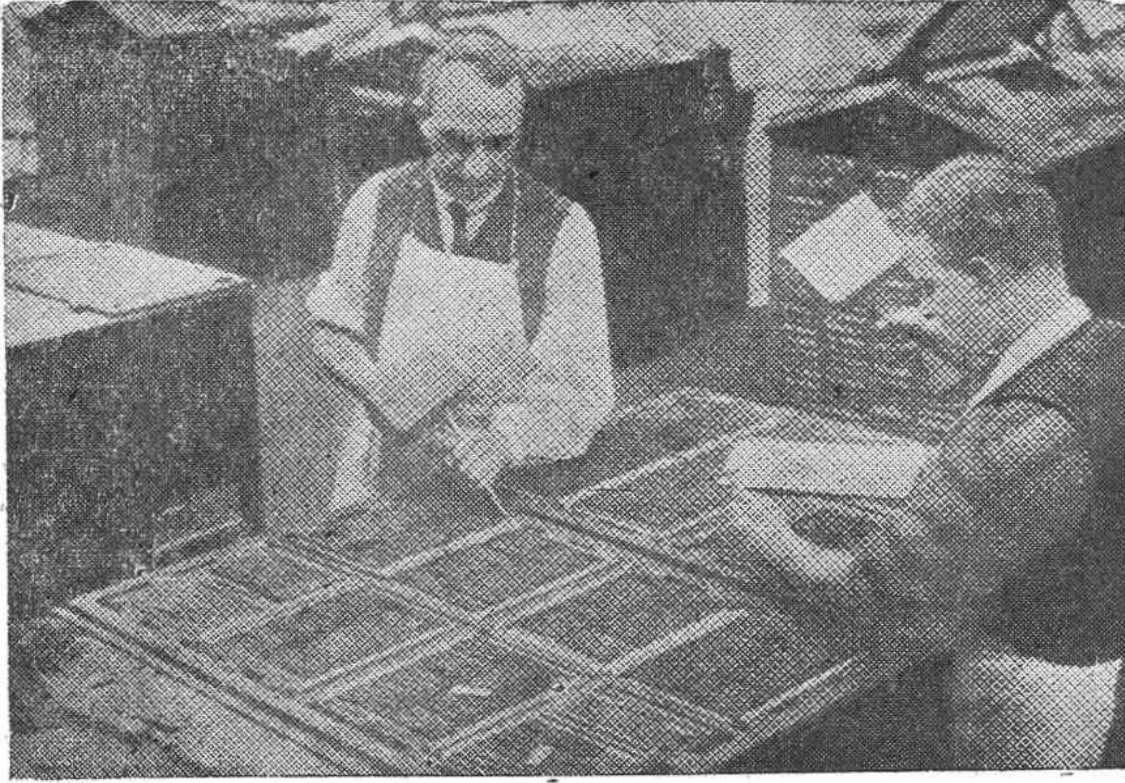
شكل ( ١٢٧ ) الصفحة المجموعة واطارها ، موضوعة على الحجر
