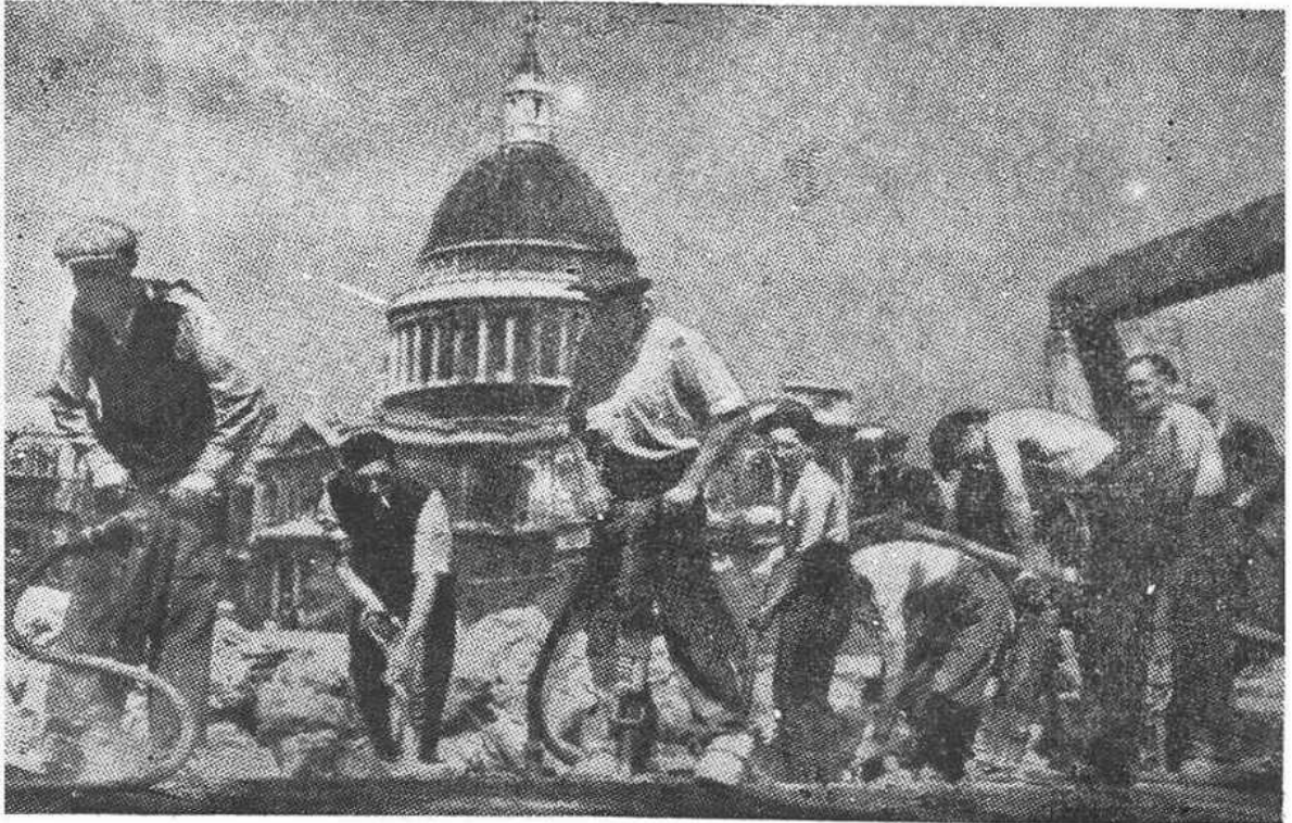
شكل ( ١٣٥ ) تكسر سطح الطريق بواسطة آلات الثقب
