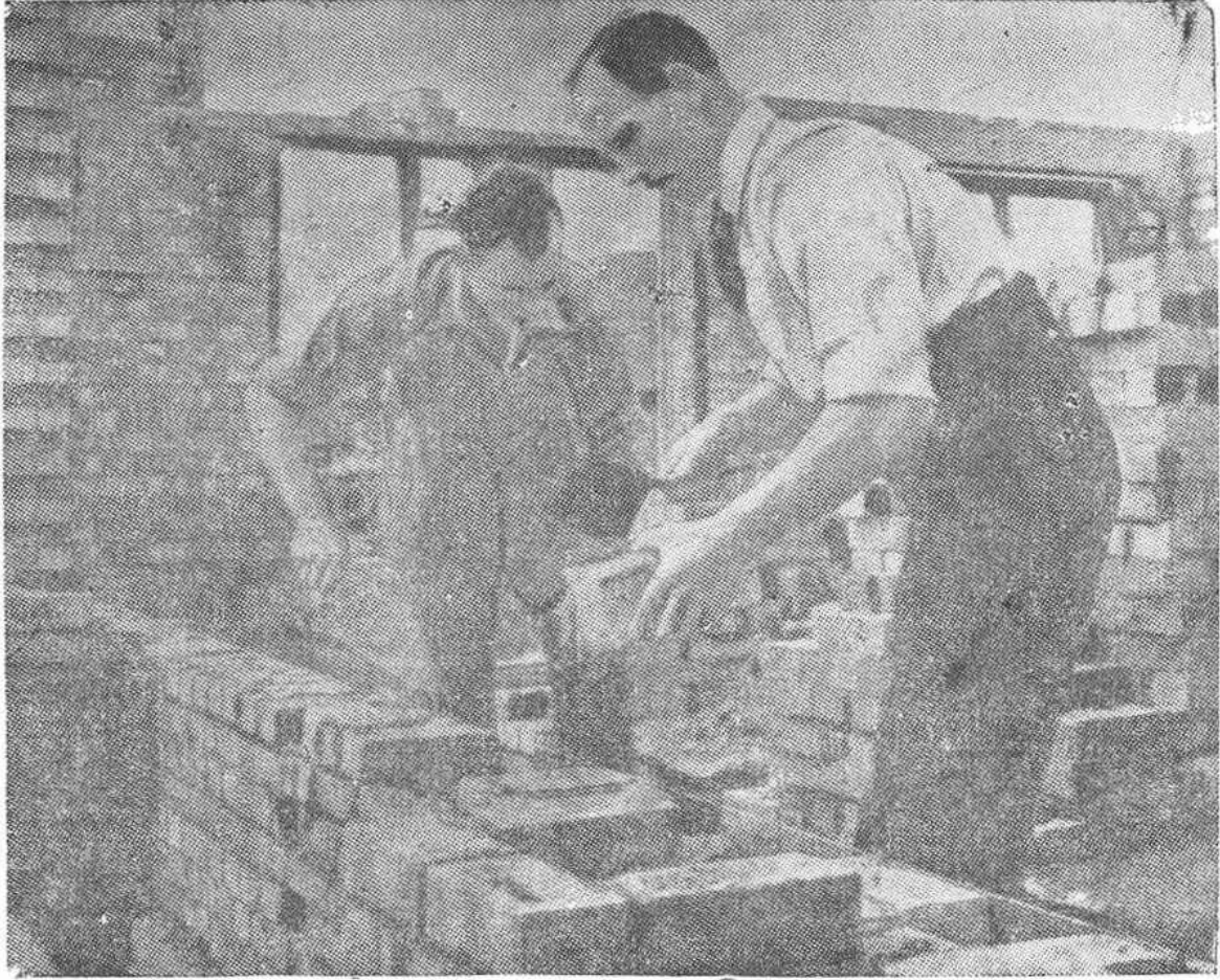
شكل (٦٥) البناءون يبنون صفا
