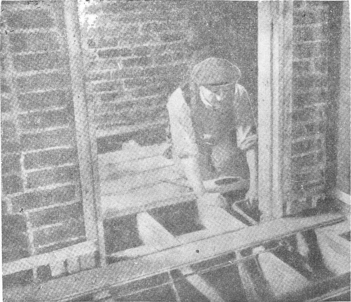
شكل (٦٩) تثبيت الانابيب المعدنية التي توضع بداخلها الاسلاك الكهربائية
