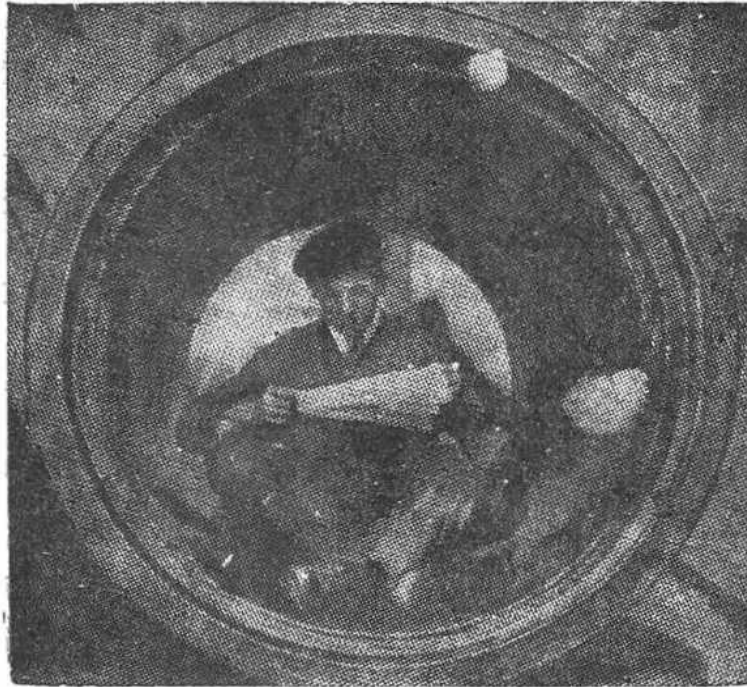
شكل ( ١٦٢ ) أنبوبة لنقل الماء ، قطرها ٤٨ بوصة
