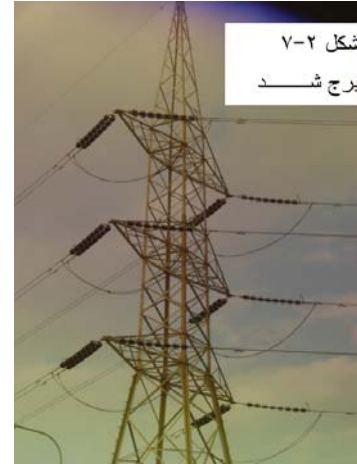
شكل ٨-٢ برج حديدي لخط جهد ٣٤٥ ك ف-زاوية
