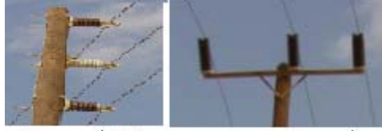
(أ) أذرع مستعرض (ب) أذرع كثيفة شكل ٢-٥ هيكله العמוד الخشبي
