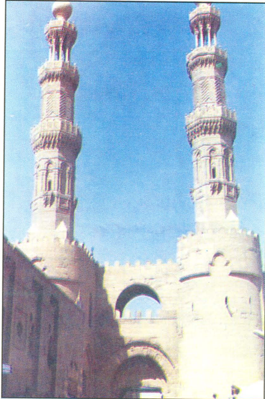
اللوحة رقم (١٥) باب الفتوح، الكابولي، السقاطات، وزخارف العقد
