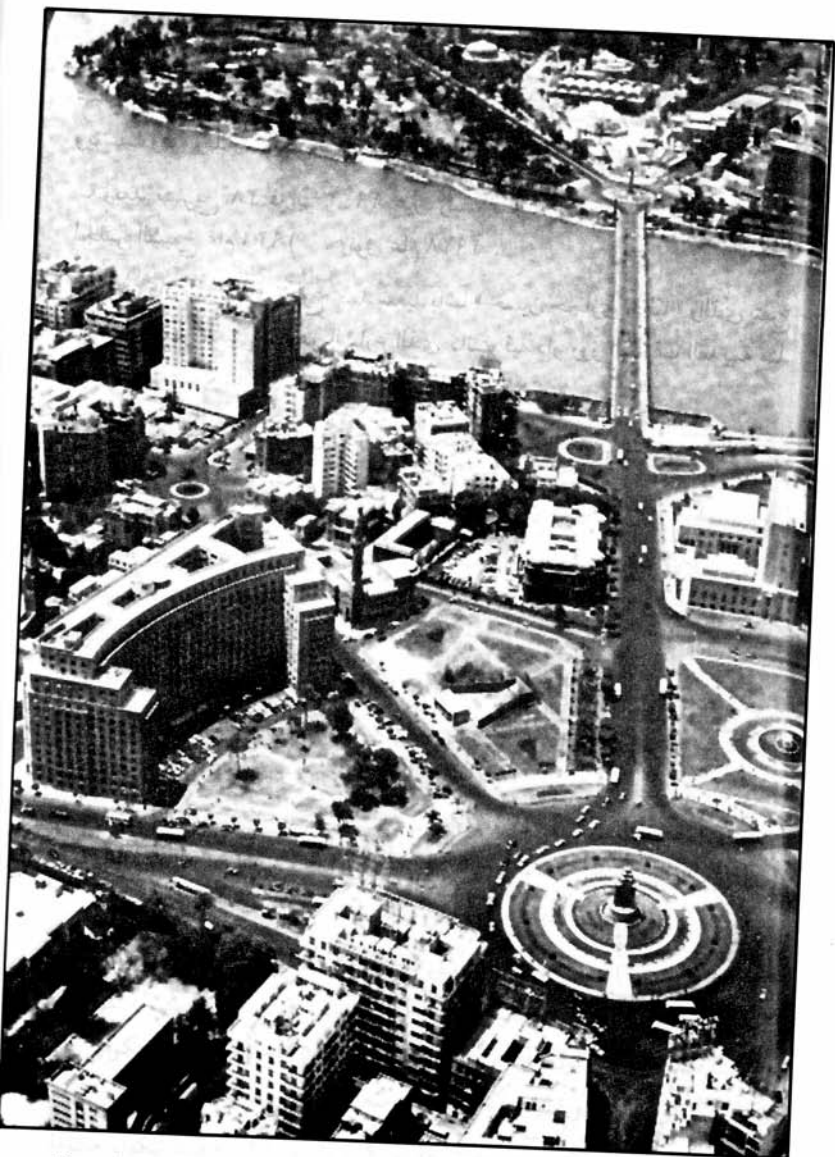
صورة من الجو لميدان التحرير على يساره المجمع وبداية حى جاردن سيتي ، تتوسطه القاعدة التى كان سيوضع عليها تمثال إساعيل باشا .
