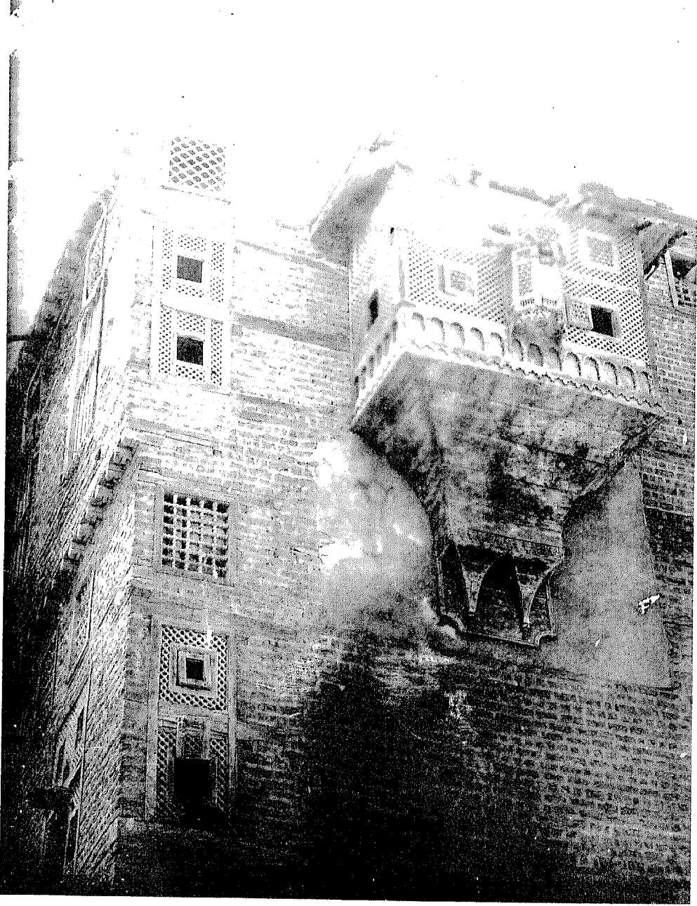
منزل الطوقانلى - مشربية على الواجهة الشرقية
